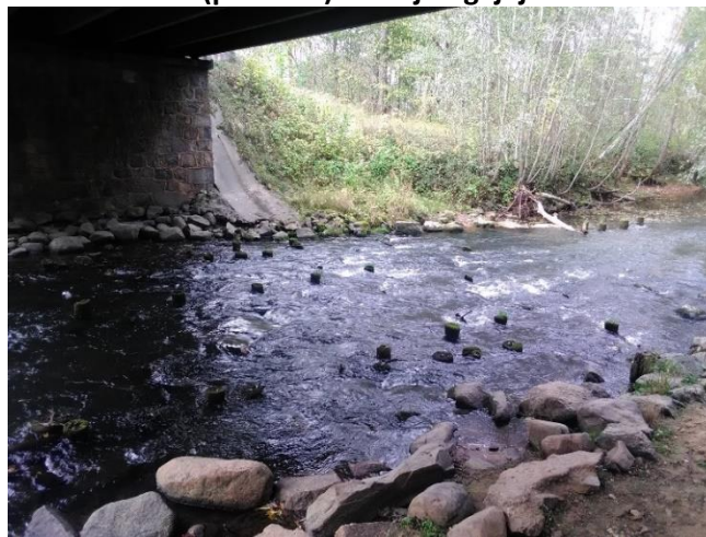
5.attēls. Tilts ar vidēju ietekmi: nostiprināti (RI) krasti, bet gultne ir nosacīti dabiska. Redzami lieli viļņi ar putām (BW).
