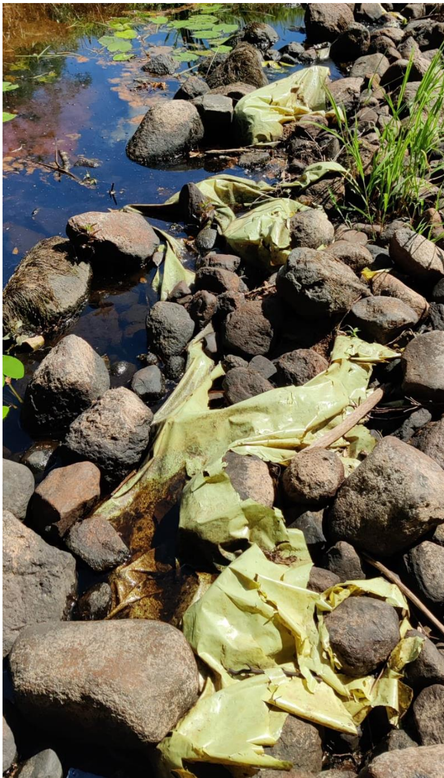
1.2.5. attēls. Akmens krāvējs Glāžupē, kas vietām nostiprināts ar plēvi (I.Kokorītes foto)
